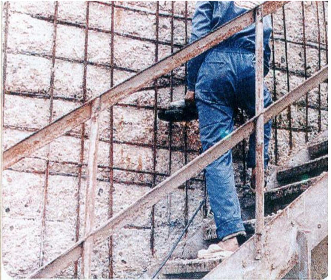
تنظيف صلب التسليح باستخدام الأجهزة الكهربائية
